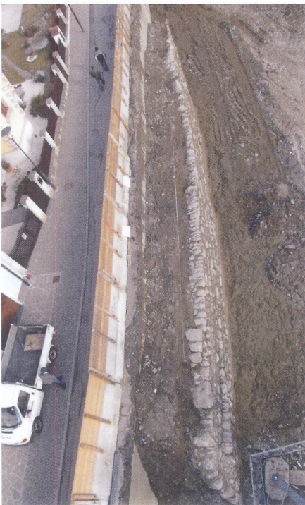
Abb. 3. Baulos 3 umfasst den mittleren Teil des Platzes.
