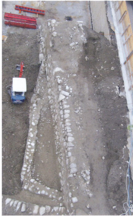
Abb. 2. Baulos 2 umfasst den südlichen Abschnitt des Platzes.
