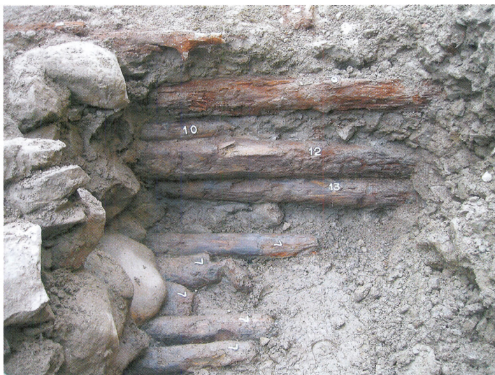
Abb. 12. Detailaufnahme der übereinander gelegten Holzbalken aus Baulos 1. Blickrichtung Norden.
