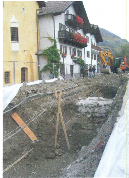
Abb. 18. Ausgrabung am Marktplatz in Klausen. Panoramaaufnahme südlich des Turms.
